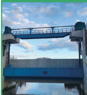
ゲート駆動装置(大型チェーン式)
